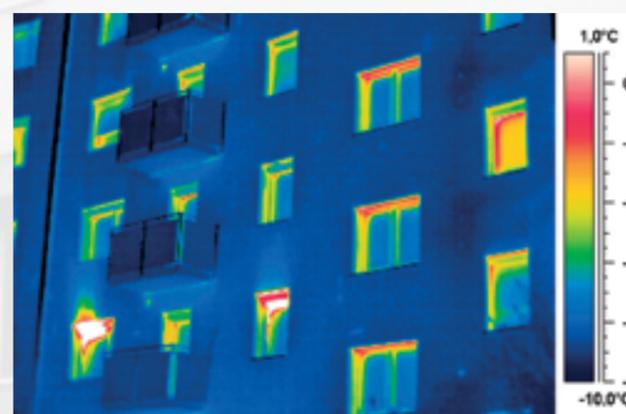
Gute Ausführung der Wärmedämmung über die gesamte Fassade. Es ist ein Effekt zu beobachten, der sich öfters bei sanierten Gebäuden zeigt: Die Heizleistung wurde nicht an den verringerten Energiebedarf nach der Sanierung angepasst, weshalb Fenster gekippt werden - falsches Nutzerverhalten.
