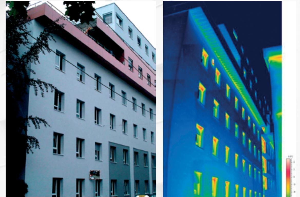
Abbildung: Tagbild und Thermografieaufnahme nach der Sanierung
